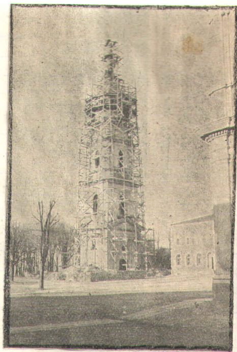
Dzwonnica w stanie przebudowy. 1938 r.
